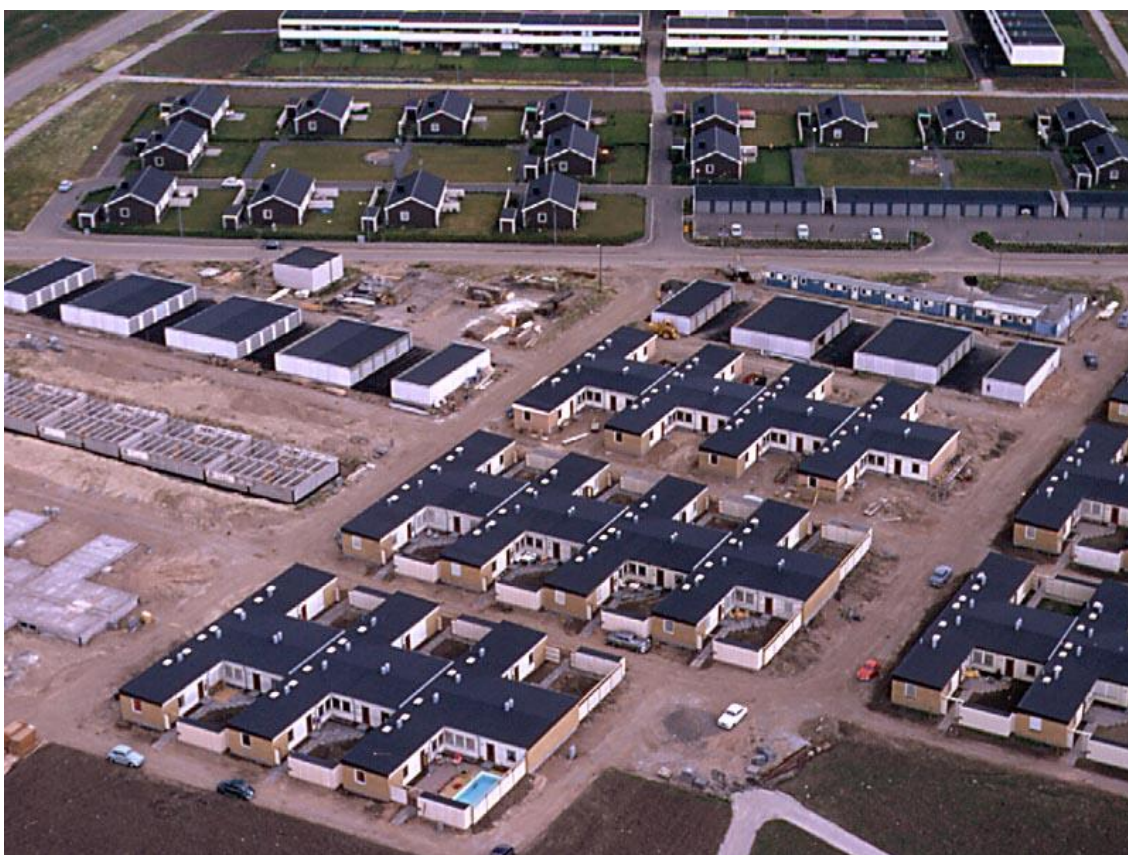
Bild 9. Flygfoto över Advokaten under uppförandet (Foto: Ingvar Bokander)
