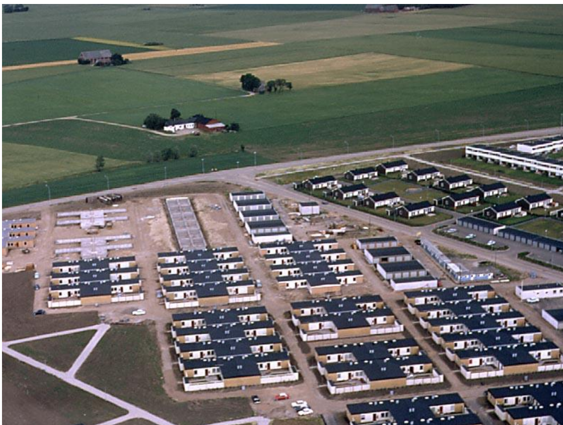
Bild 8. Flygfoto över Advokaten under uppförandet (Foto: Ingvar Bokander)
